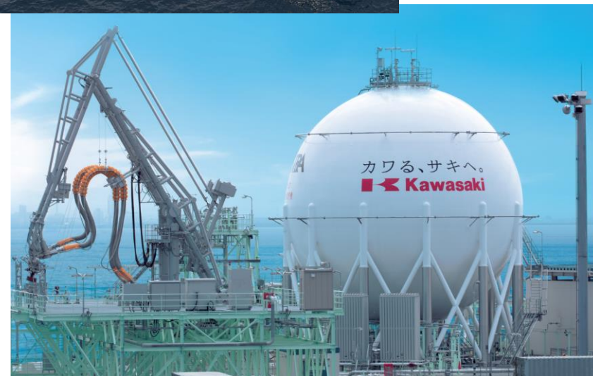
液化水素 貯蔵タンク
