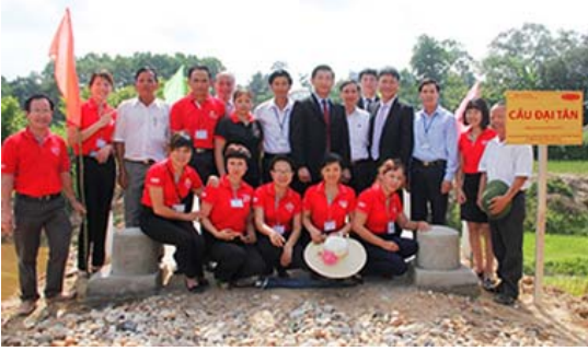
橋の建設現場（ベトナム：第一生命ベトナム）
