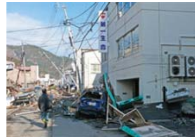
被災直後の釜石営業オフィス
