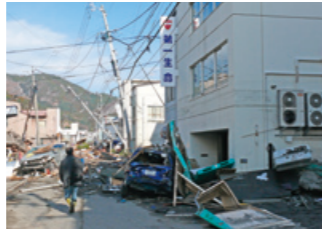
被災直後の釜石営業オフィス
