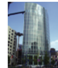
梅新第一生命ビルディング (平成19年10月竣工)
