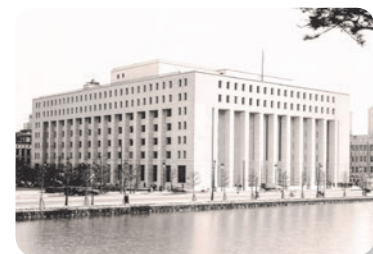
1938年に完成した「第一生命館」
